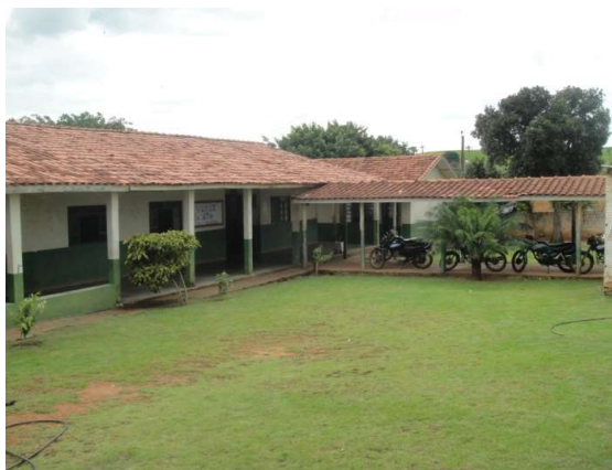
Figura 1 – Vista lateral da escola
